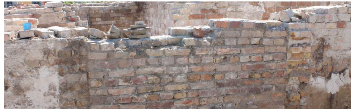
Vermauerter Durchgang eines Bahngeländes
