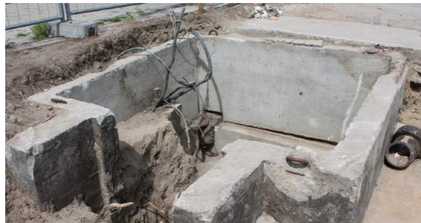
Grabung am Nordbahnhof - Fundament eines DDR-Wachturms
